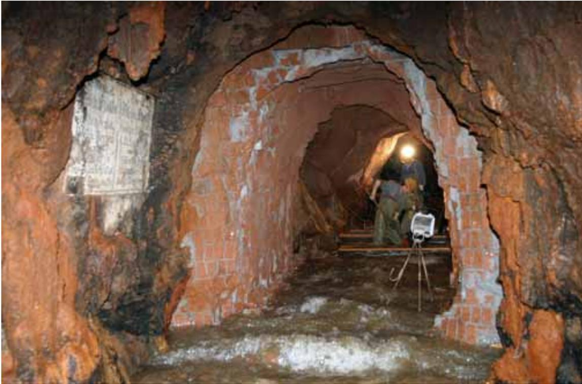
**Rothschönberger Stollen - Herstellung der Funktionsfähigkeit durch Aufwältigung abgedämmter Bereiche (Foto: Sächsisches Oberbergamt)**
