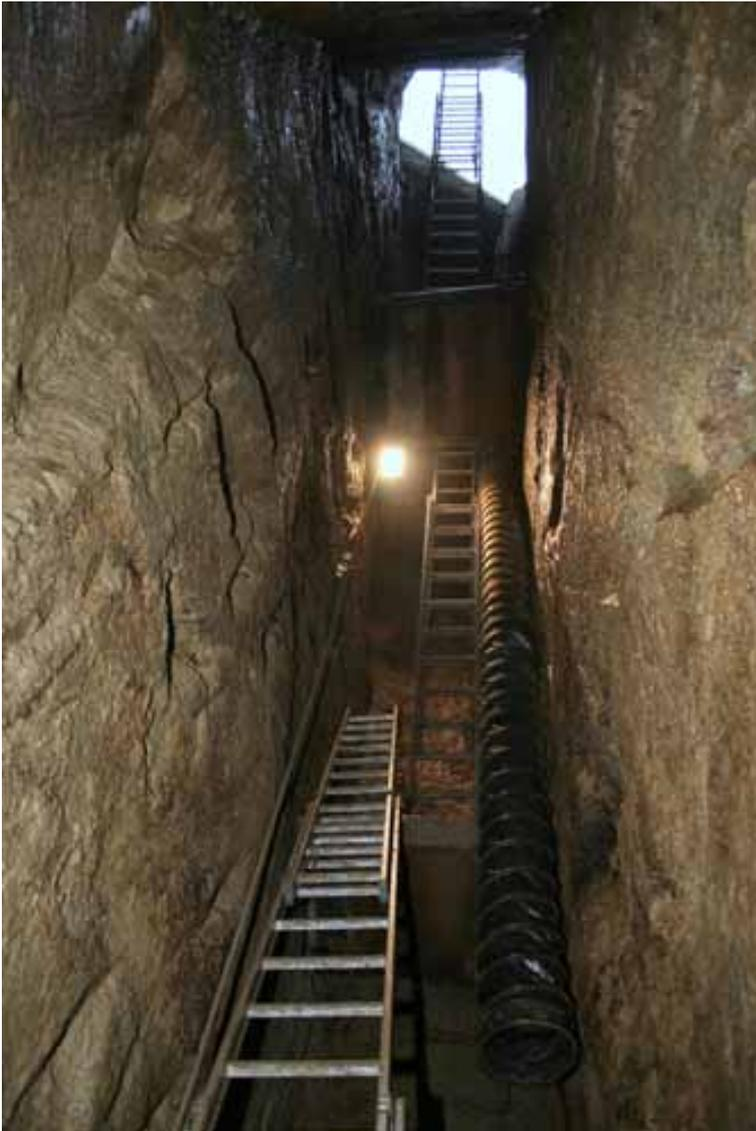
**Aufwältigung des Tagesbruches auf dem Hilfe-Gottes-Tagesschacht in Halsbrücke**
