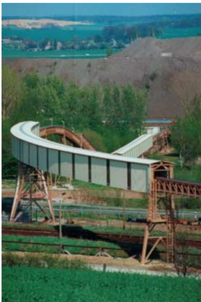
**Pipe-Conveyor – Geschlossener kurvengängiger Gurtbandförderer zum Transport von Bergematerial des Standortes Crossen zur Sanierung der Absetzanlage Helmsdorf**
