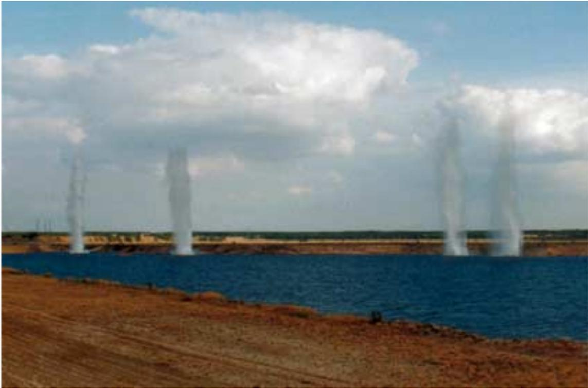
**Sprengverdichtung - Testsprengungen vor der Innenkippe des Tagebaus Scheiße**
