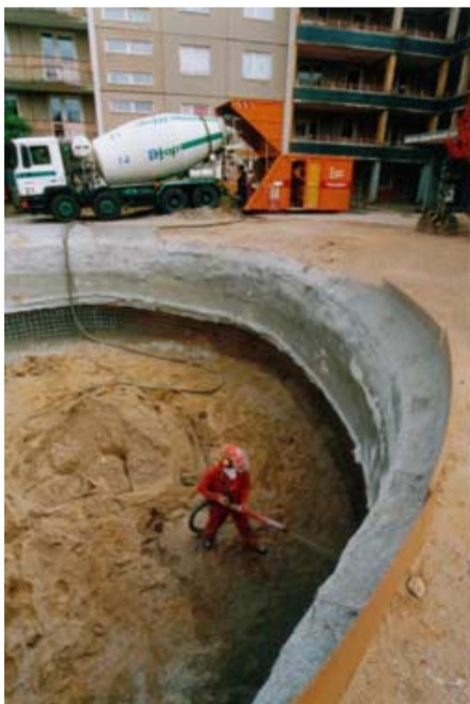
**Anlage eines Horizontalfilterbrunnens in Hoyerswerda**
