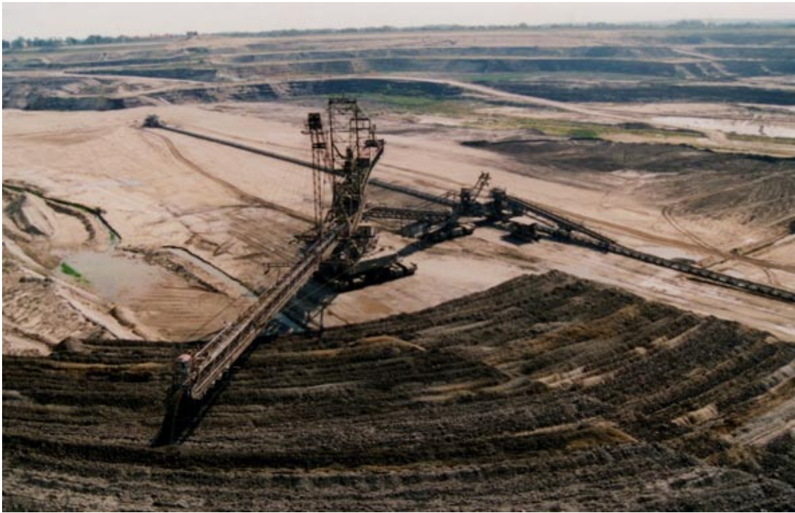
Absetzer in der Hochschüttung (Stützkippe im Tagebau Berzdorf) (Foto: Bergamt Hoyerswerda)
