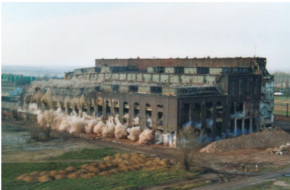
Sprengung des Kraftwerkes I in Espenhain am 15.04.2000 (Foto: LMBV mbH)
