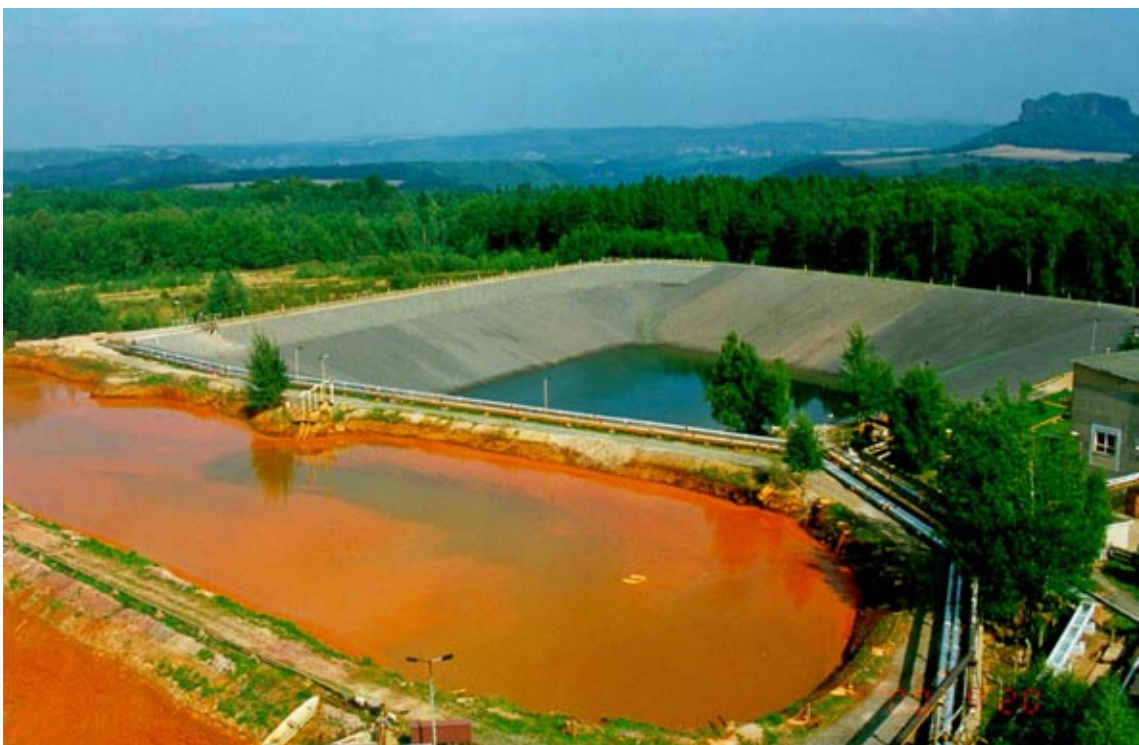
Klarwasserschönungsbecken, Sanierungsbetrieb Königstein (Foto: Wismut GmbH)
