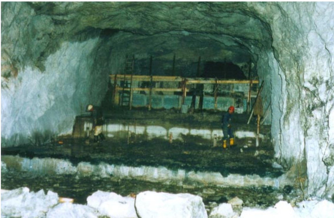
Versatzeinbringung im Kalkbergwerk Oberscheibe (Foto: GEOMIN)
