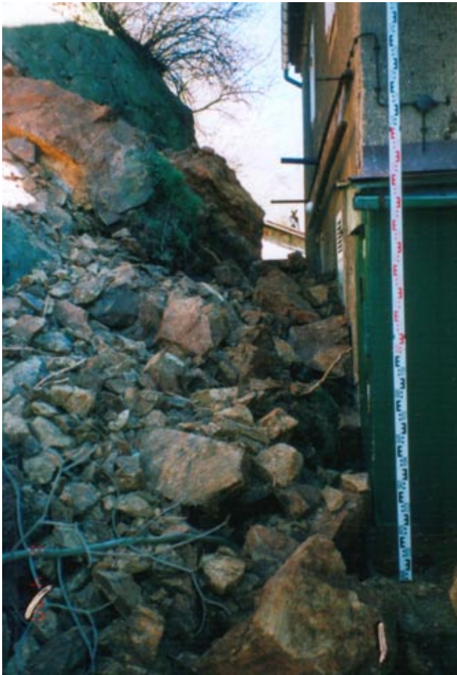
Felsrutschung in Leuben, Lommatzcher Straße (Foto: Geomontan)
