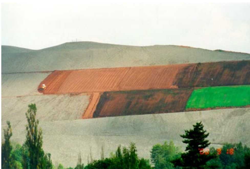
Abdeckung der Halde 366, Aue-Alberoda (Foto: Wismut GmbH)
